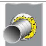
2. Dolgu malzemesini yerleştirin
